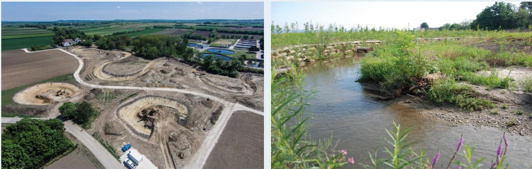
Aufgrund der großzügigen Grundverfügbarkeit wurde ein neuer Flussverlauf geschaffen, der in Form und Ausgestaltung der Wulka im natürlichen Zustand entspricht. Die ursprüngliche Lauflänge wurde um 100 % durch sieben Mänderschleifen verlängert, mit Prall- und flach auslaufenden Gleitufeln bzw. flachen Furten und tiefen Kolkbereichen. In den Böschungsbereichen und auf ebenen Flächen, erfolgte eine Initialbepflanzung mit standortgerechten Gehölzen.
